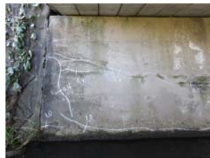
コンクリートのひび割れ
