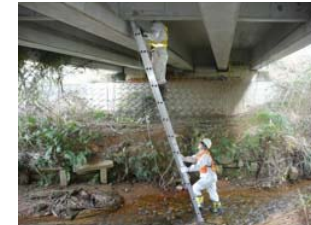
■橋梁点検の様子
